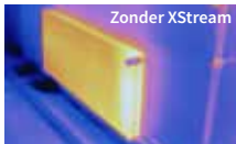
Radiator met luchtblokkades boven en vuilblokkades onder
