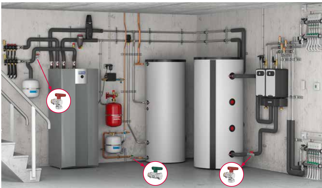
Příklad: malá technická místnost
