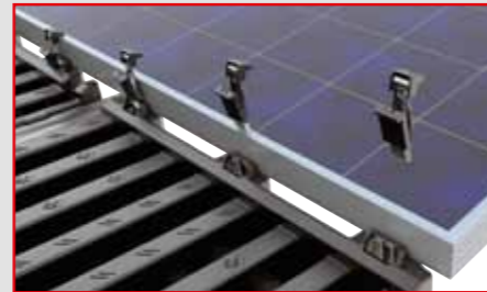
Befestigen der PV-Solarmodule mit Clips und einführen der Kabel in die Kabelkanäle
